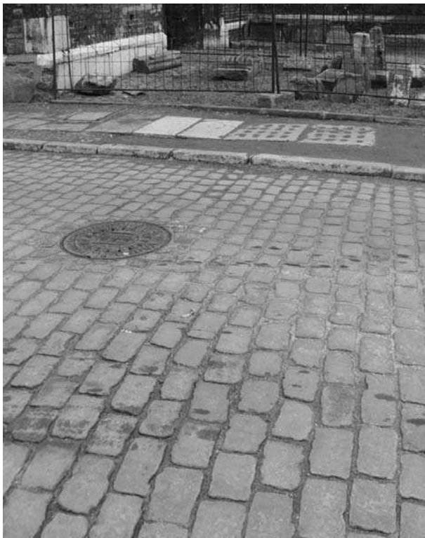
11. Odslonięta nawierzchnia brukowa na ul. Minogi, fot. J. Friedrich
