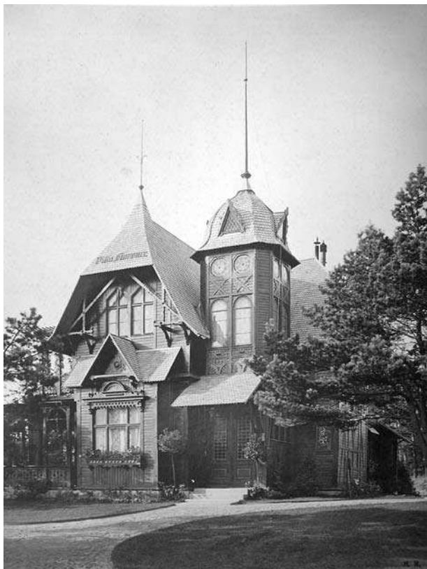
4. Heringsdorf, willa „Florence”, Tabl. 4 w katalogu Wolgaster Actien-Gesellschaft für Holzbearbeitung vorm. J. Heinr. Kraeft: Import amerikan. Hölzer; Bau v. zerlegbaren Holzhäusern..., Wolgast [1900]
