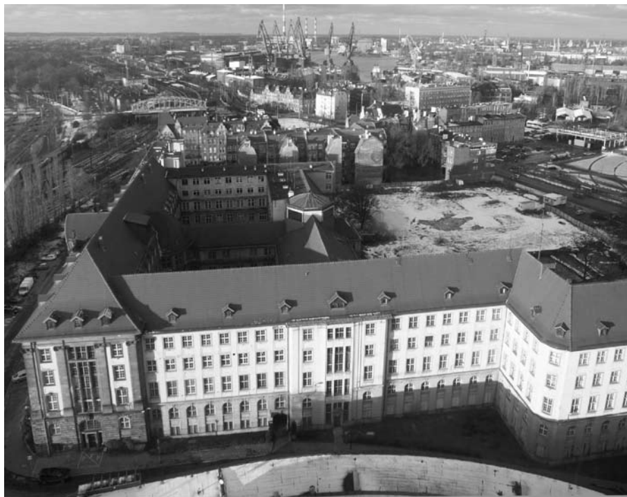
Il. 1. Gmach Dyrekcji Kolei w Gdańsku. Fot. T. Strug
