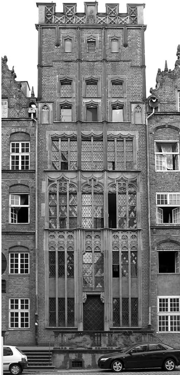
Il. 16. Fasada domu gotyckiego przy ul. Chlebnickiej 14 w Gdańsku po rekonstrukcji przeprowadzonej w latach siedemdziesiątych wg projektu Kazimierza Orłowskiego, fot. M. Omilanowska
