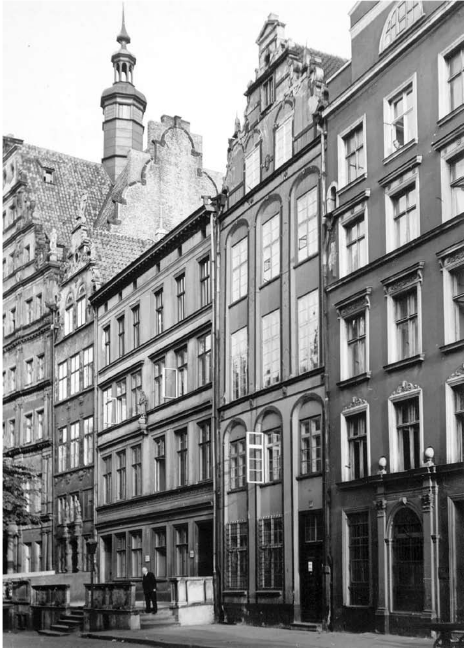
Il. 15. Klasycystyczna kamienica wzniesiona na miejscu domu gotyckiego przy Chlebnickiej w Gdańsku, fot. Instytut Herdera w Marburgu, sygn. 4d2498
